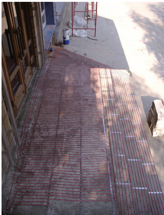
Фото 3. Монтаж системы снеготаяния на крыльце.
