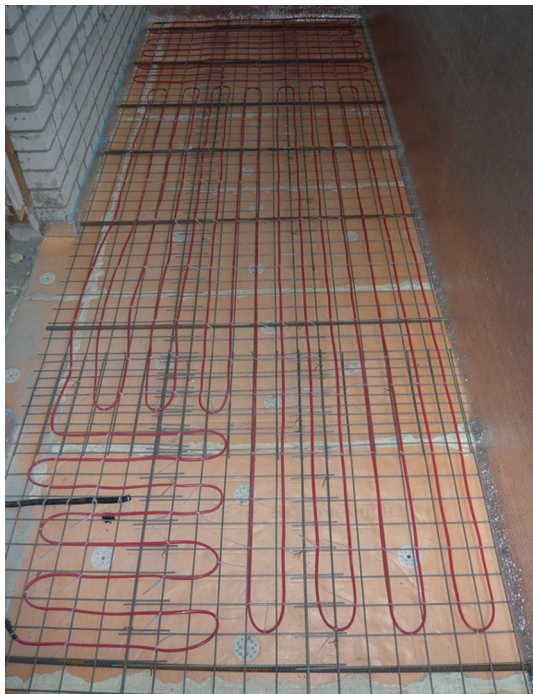
Фото 1. Монтаж теплого пола на утепленном балконе.
